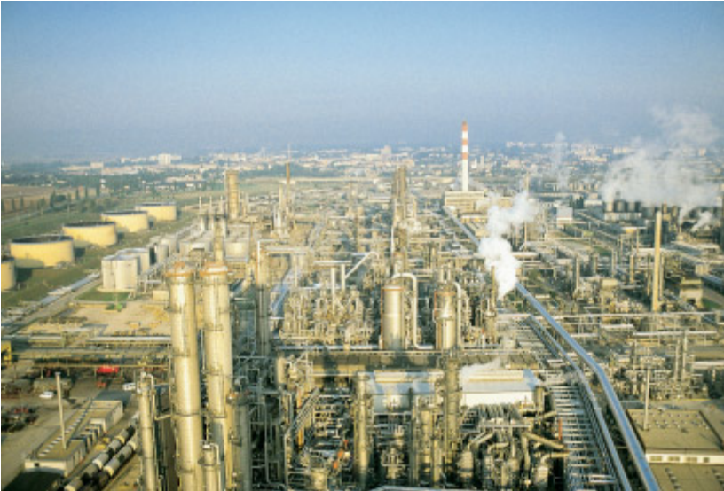
Die OMV-Raffinerie in Schwechat bei Wien ist eine der modernsten Anlagen Europas: Über 700 Produkte werden hier bei größtmöglicher Umweltschonung hergestellt.
