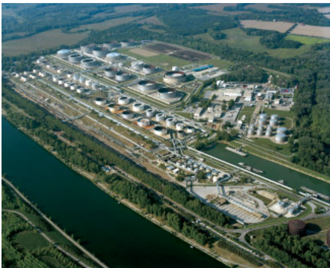
Das Tanklager Lobau ist durch Rohrleitungen mit der Raffinerie Schwechat verbunden. Hier entstehen die Endprodukte Benzin, Diesel und Heizöl Extraleicht. Die Produkte werden mit Tankwagen, Kesselwaggons, Schiffen oder Produkten-Pipelines weiter transportiert.
